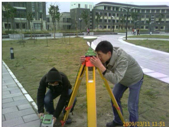
DGPS 测量现场
